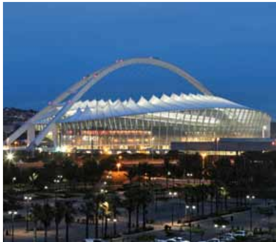
Stadion in Durban: Der „Himmelsbogen“ hält das textile Dach.
